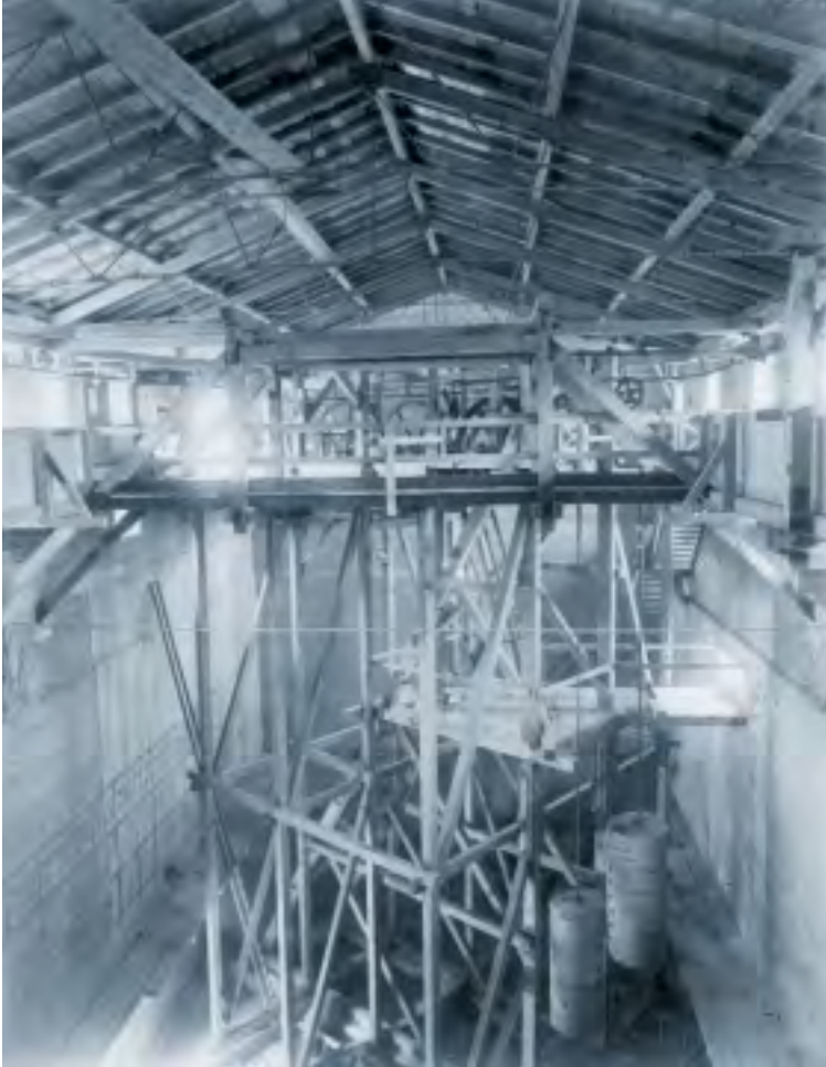
Entladestation der Drahtseilbahn im »Cementstein-Magazin« mit einer Höhe von 15 Metern, ca. 1898.
