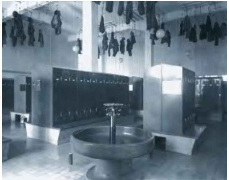
Neu errichtete Wasch- und Umkleieräume im umgebauten alten Verwaltungsgebäude, Ende 1937.
