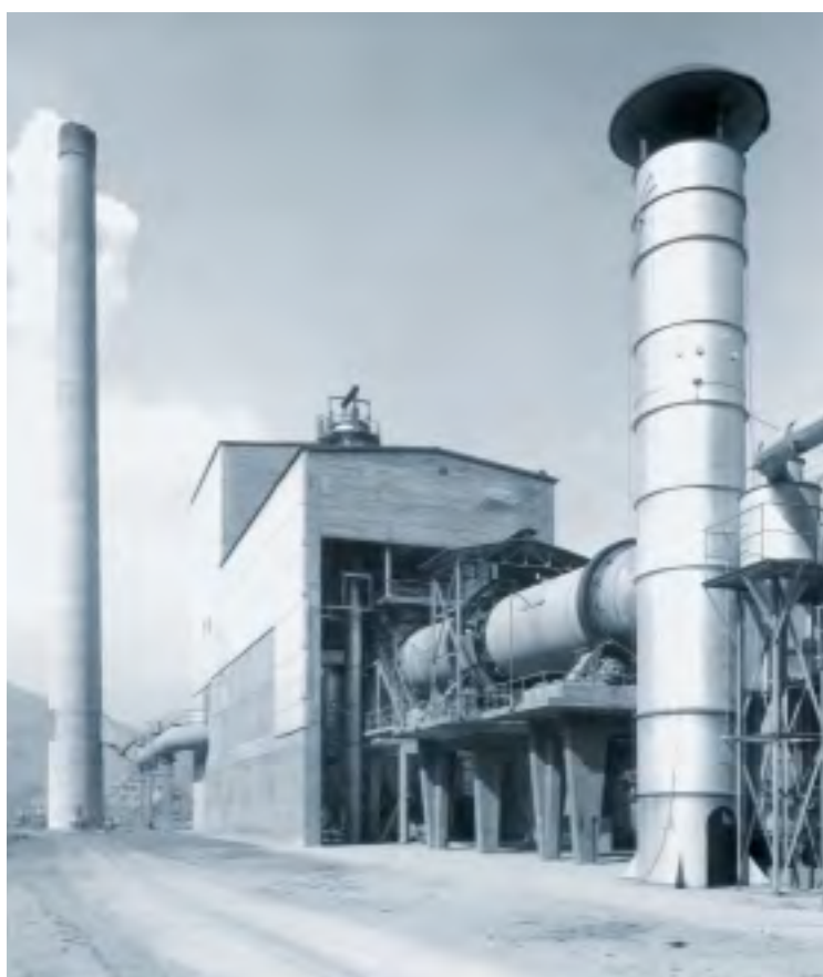
Ofengebäude des Lepolofen II, 1965.
