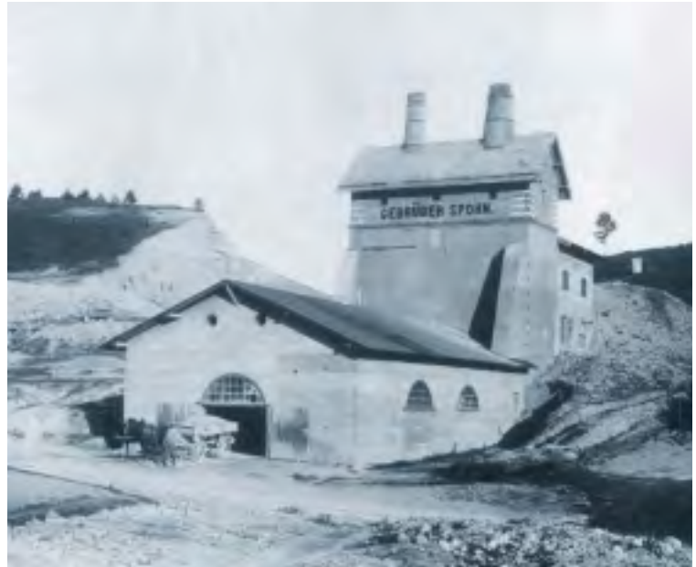
Steinbruch und Schachtöfen der Firma Spohn in Allmendingen, um 1890.
