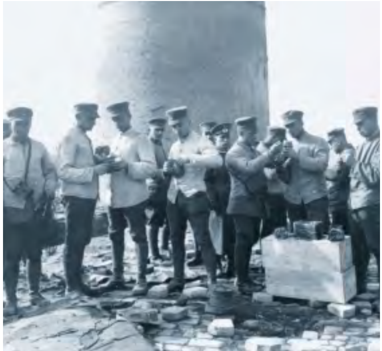
Vorbereitung der Sprengung des 60 m hohen Schornsteins der Ringöfen II und III durch Pioniere aus Ulm 1936. Oberst Kreuzer hatte mehrfach Georg Spohn gebeten das Kamin sprengen zu dürfen. Nach der Sprengung waren die in die umliegenden Felder gefallenen Steine rasch von Steinesammlern aufgelesen.
