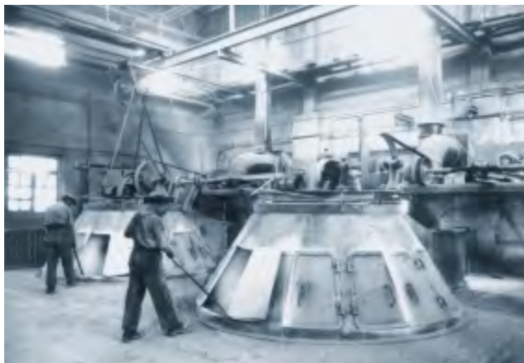
Arbeiter auf der Schachtofengichtbühne beim Abstoßen der Anbackungen, ca. 1918.
