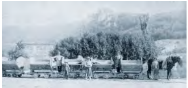
Die Pferdebahn transportierte fast 20 Jahre das gebrannte Rohmaterial von den Öfen in Gerhausen nach Blaubeuren. Die Überwindung des Ruckenstichs verlangte von den Pferden größte Kraftanstrengung.
